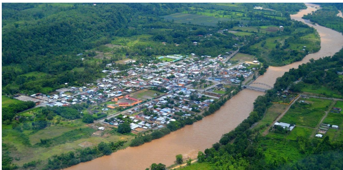
Foto: Riesgos por Inundación por desbordamiento del Río Blanco, en la Parroquia Valle Hermoso. Cortesía Sr. Tex Montes De Oca
